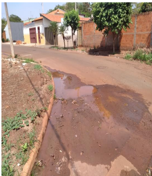
Figura 02 -- Vista do local ilustrando buraco na pavimentação asfáltica, o que poderá gerar desconforto aos munícipes que transitam em referida via.
