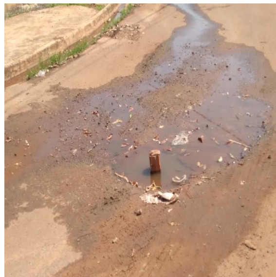
Figura 02 -- Vista do local ilustrando buraco na pavimentação asfáltica, o que poderá gerar desconforto aos munícipes que transitam em referida via.
