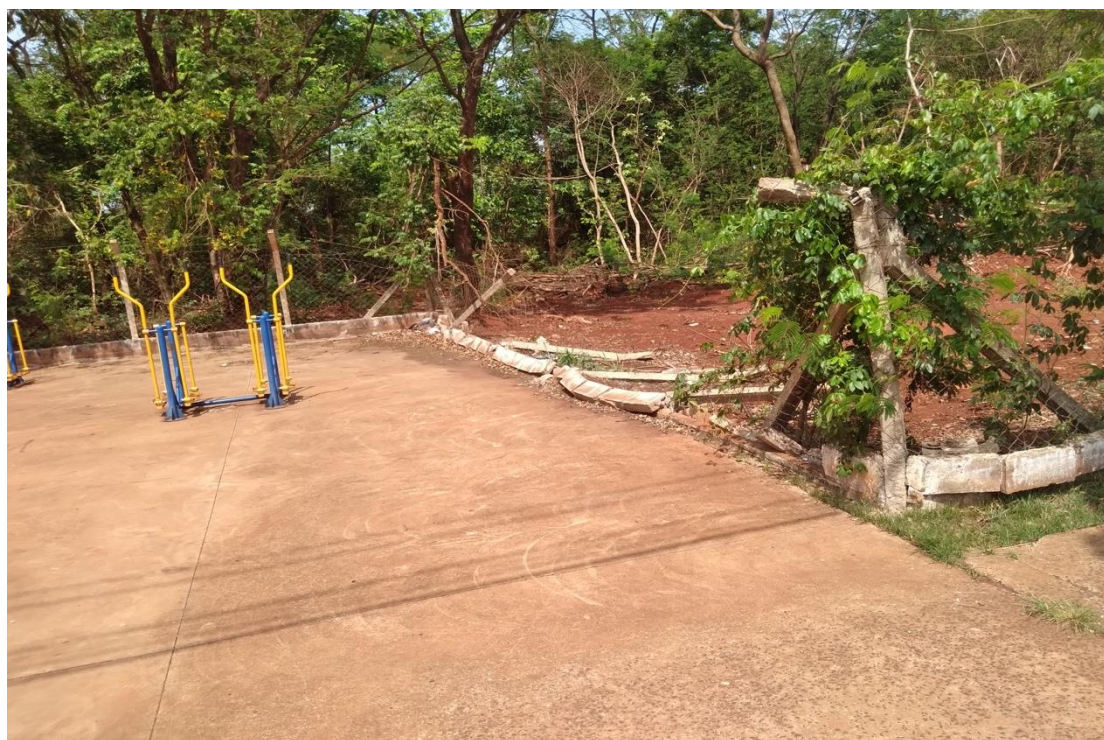
Figura 04 -- Vista do local apontando um dos pontos onde necessita de reparo a cargo do Poder Público Municipal.
